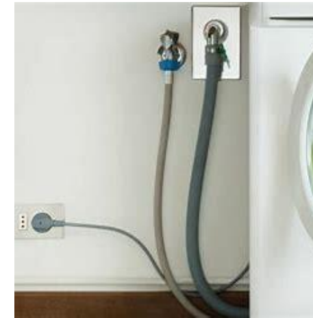
Waschmaschinenanschluss
