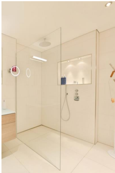
Bodengleiche Dusche (mit einem Rollstuhl befahrbar)
